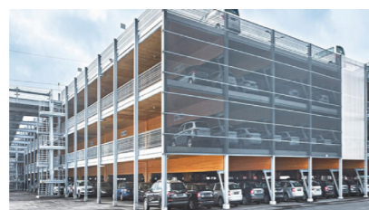
2 Parkhaus (im Bau)
