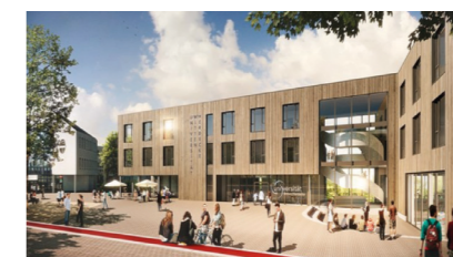
5 Neubau der UW/H (Fertigstellung im August 2021)
